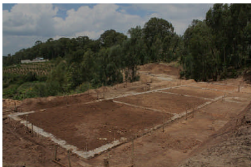
【基礎工事が完了しました！】
