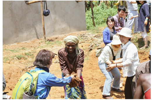
<家造りで泥のバケツリレー>
